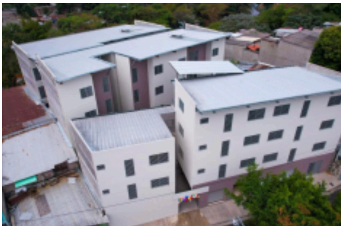
Figura 4. Proyecto habitacional para 40 familias de la cooperativa de vivienda de ayuda mutua ACOV-UVD, ubicado en el barrio San Esteban.
